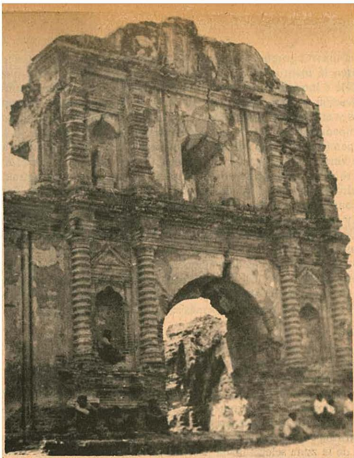
Lámina XXVI.- TACUBA: ruinas de la Iglesia colonial destruída por un terremoto.
