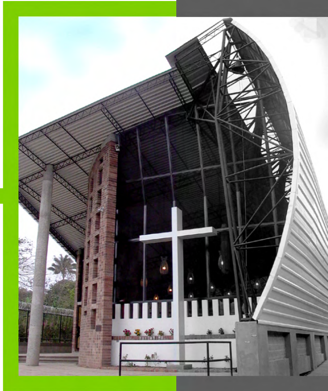
Vista Poniente-Oriente del edificio
