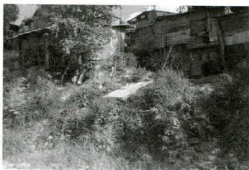
Fig. 11 Vivienda de lámina, cartón y plástico, en zona de alto riesgo/ Iberia A y B.
