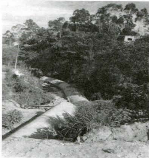
Fig. 15 Vista parcial de la bóveda en construcción.
