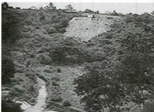
Fig. 14 Vista parcial de Quebrada
