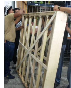
Prefabricación de cajones
