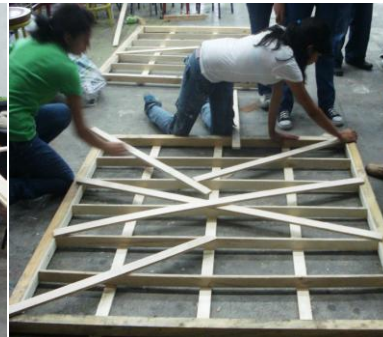
Prefabricación de cajones
