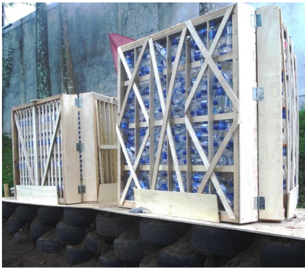
Módulos triangulares sobre muro de llantas
