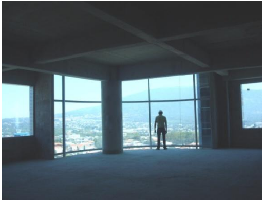
Fotografía del sitio
