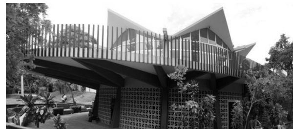
Fig. 11. Comedor Universitario UES, 1965, San Salvador. Fuente: Guía de Arquitectura de El Salvador.
