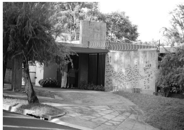
Fig. 15. Casa Díaz, 1965, San Salvador. Fuente: Guía de Arquitectura de El Salvador.
