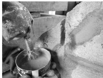
Fig. 3 Fotografía de aplicación de puente de adherencia.
