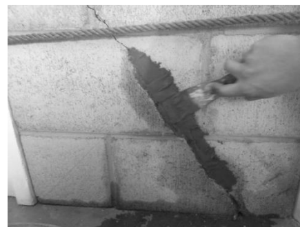
Fig. 4 Fotografía de aplicación de mortero de reparación.
